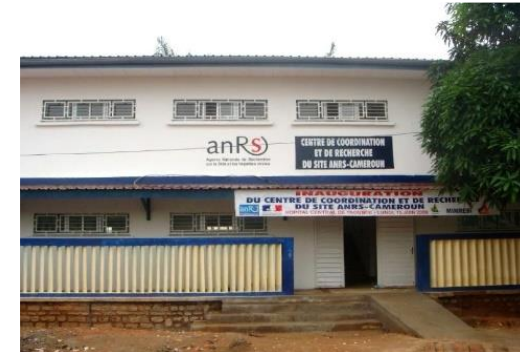
Site ANRS Cameroun Hôpital central de Yaoundé
